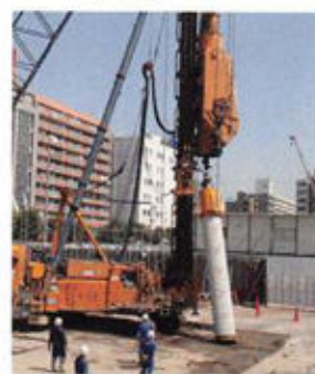
杭吊り装置(下杭)
